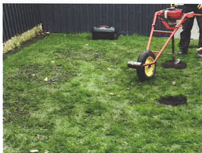
Dræningsproces med et motoriseret pælebor
